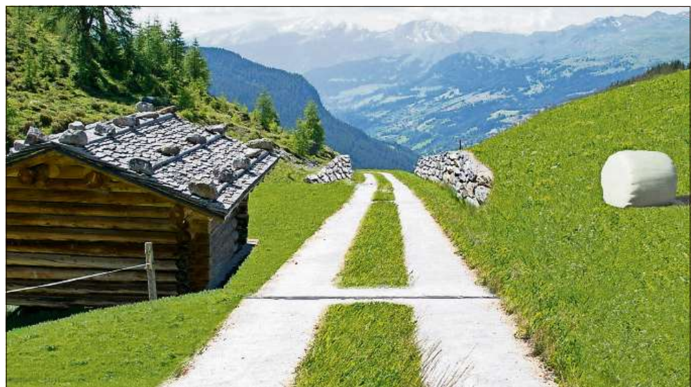
HTW-Fotomontage: Hier als Betonspurweg.
