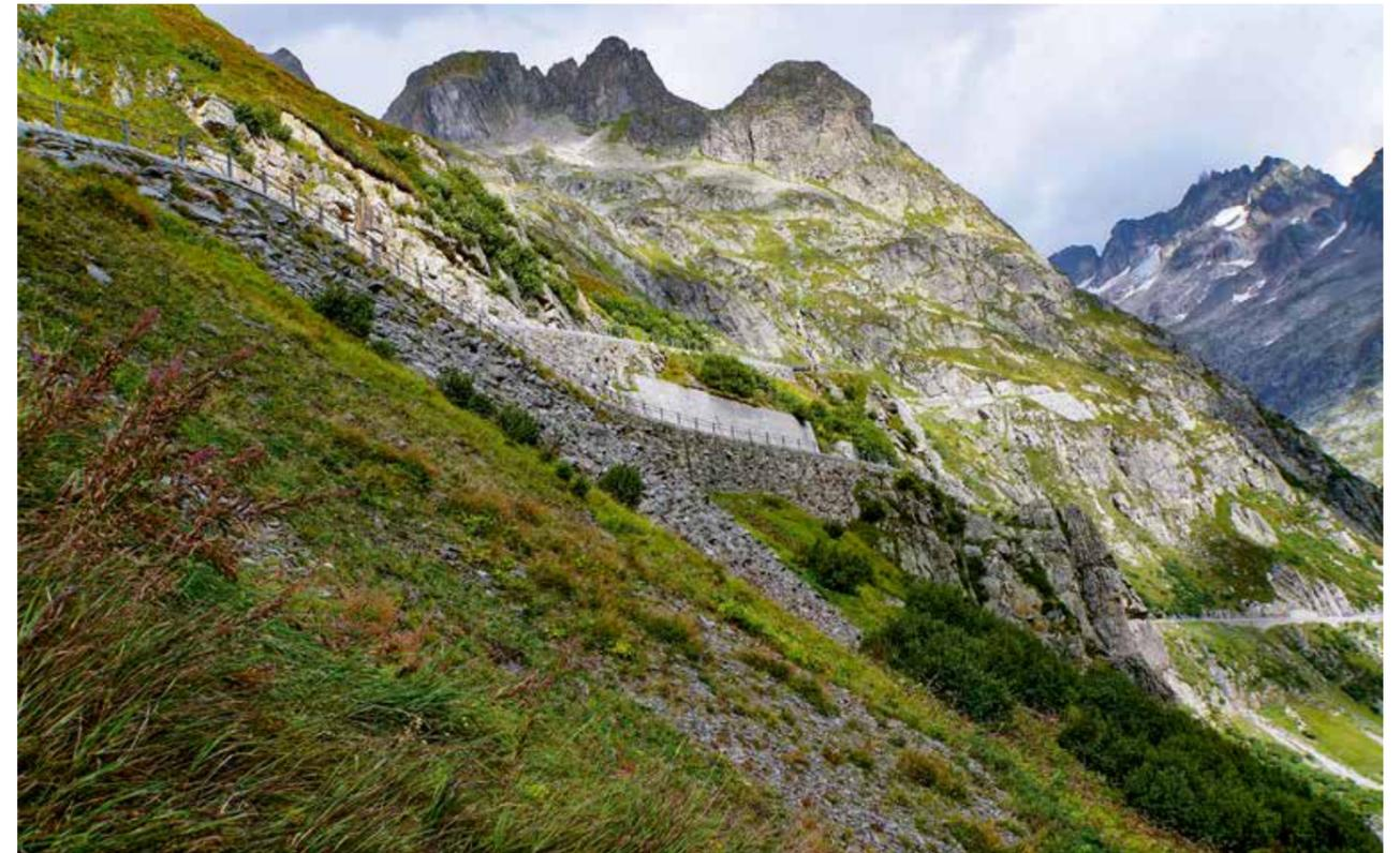
**5** Die helle Fläche einer Betonstützmauer sticht aus den Fels- und Mauerwerksflächen der Sustenstrasse in der Meienwang hervor und demonstriert die Fernwirkung dieser Bauweise. (Foto: Lars Hellmüller, 2019)
